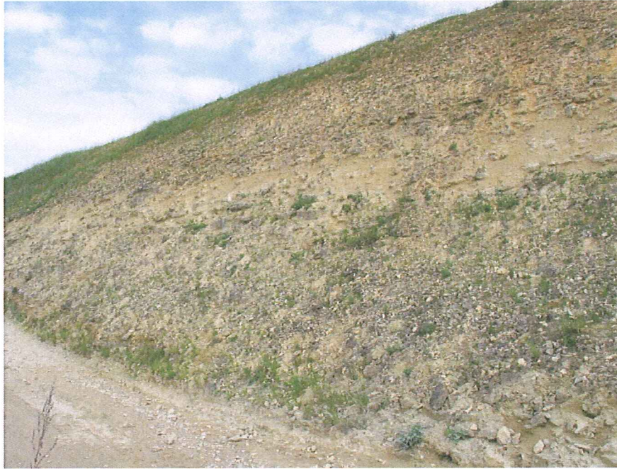
Figure 10 : Vue du front de taille Nord-Est (photo prise le 19/05/2009)
