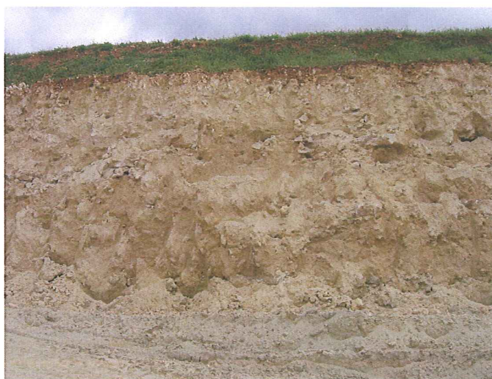
Figure 6 : Vue du front de taille Sud-Est de la carrière fortement sableux (photo prise le 06/05/2009)
